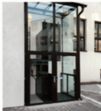
Zvislá plošina v presklenom ohradení
