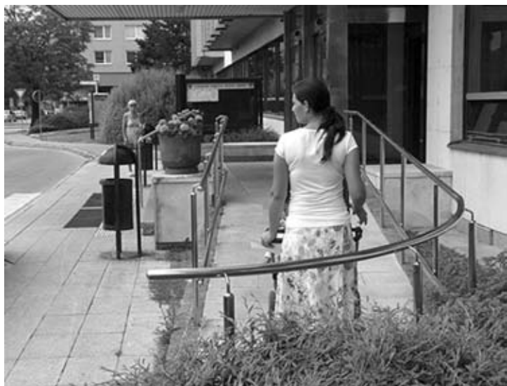
Bezbariérový vchod na Mestský úrad v Nitre
