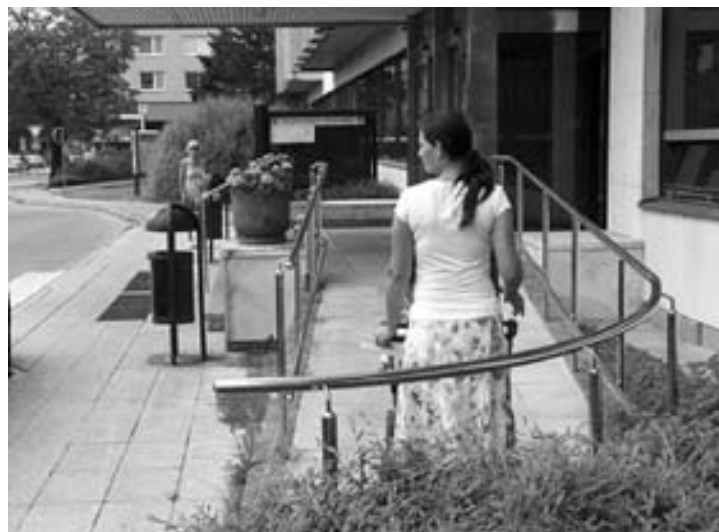
Bezbariérový vchod na Mestský úrad v Nitre
